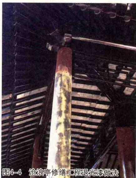
图4-4 沧浪亭修缮工程退光漆做法
